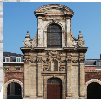
Façade de la chapelle
