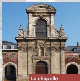
La chapelle Restitution du clocher Restauration de la façade Aménagement intérieur
